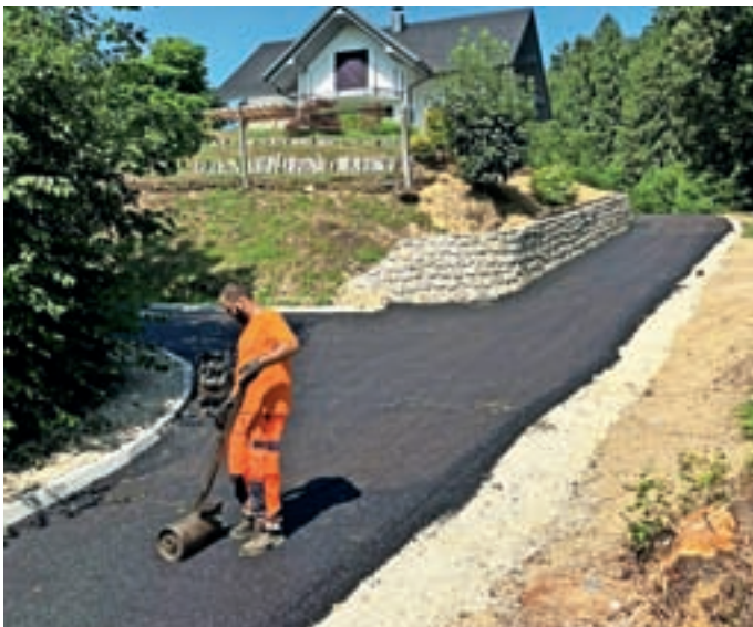
Občina je v drugem tednu avgusta asfaltirala več odsekov lokalnih cest. Foto: arhiv občine
